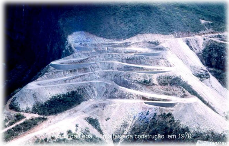
1970 - Estrada da Leba em construção
