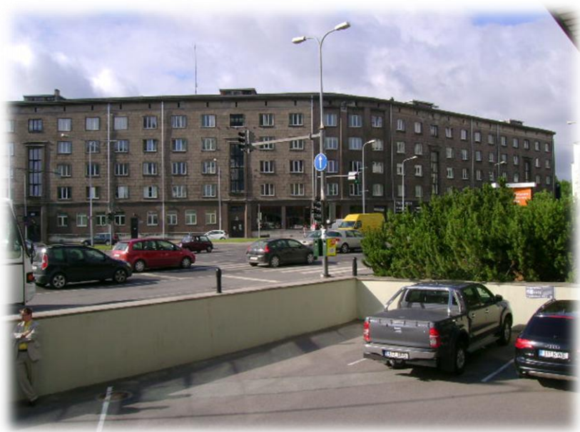
Edifício construído no tempo da União Soviética
