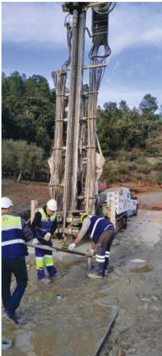
Obturação e aplicação de caldas no trecho experimental de injeções (5) – dezembro 2024
