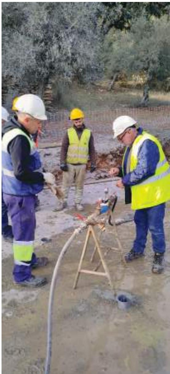
Controlo de caudais e pressões na injeção de caldas no trecho experimental de injeções (5) – dezembro 2024
