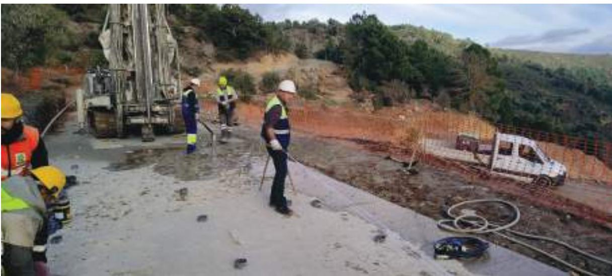
Obturação e aplicação de caldas no trecho experimental de injeções (5) – dezembro 2024
