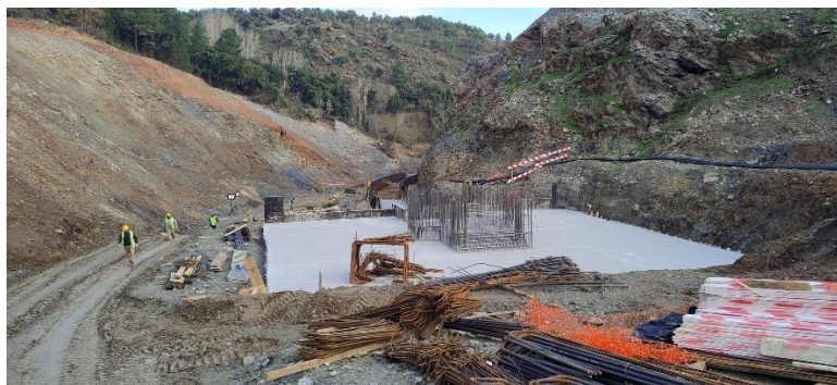
Aspeto final da sapata da torre de captação, arranque do pilar – novembro 2024
