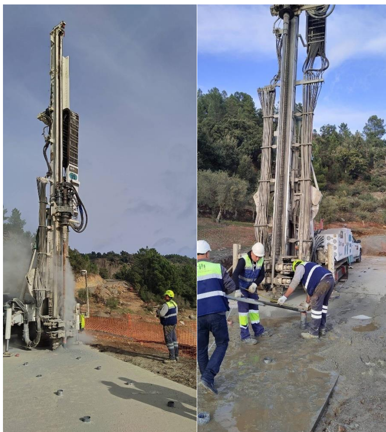
Início da furação no trecho experimental de injeções (5) – dezembro 2024
