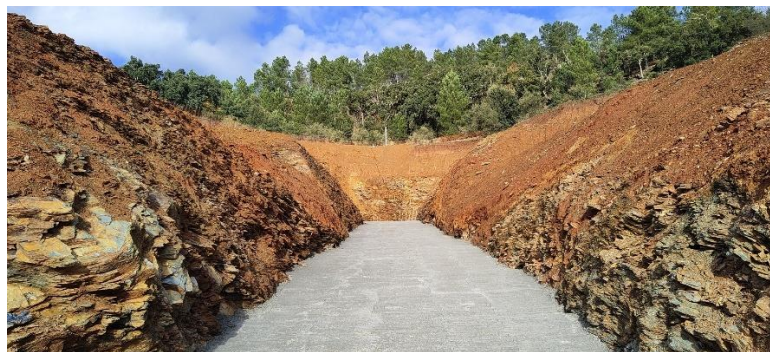
Aplicação betão regularização (Encontro direito) – novembro 2024
