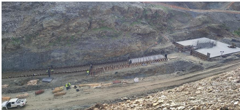
Início betonagem da laje da galeria descarga de fundo – novembro 2024
