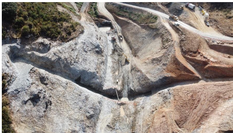
Escavação fundo do vale – setembro 2024
