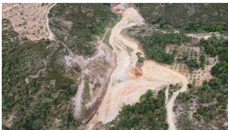
Início escavação encontro direito – julho 2024
