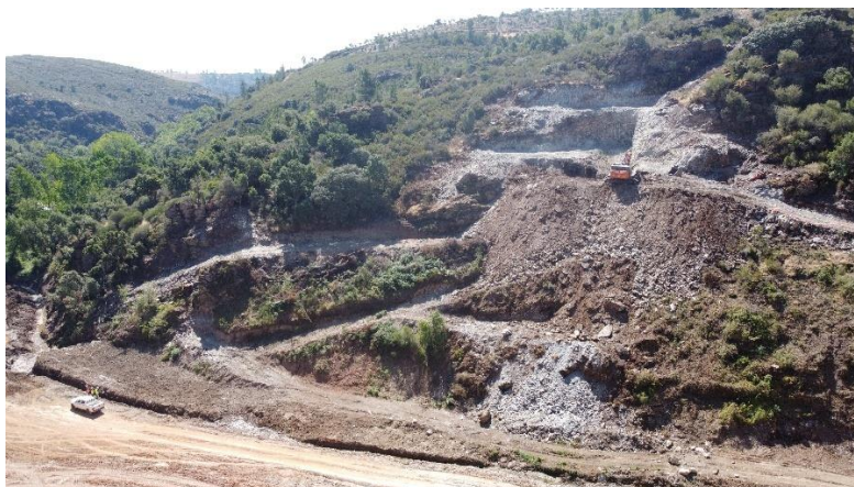
Escavação encontro direito – julho 2024
