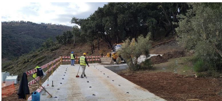
Trabalhos finais no plinto do trecho experimental de injeções (5) – novembro 2024
