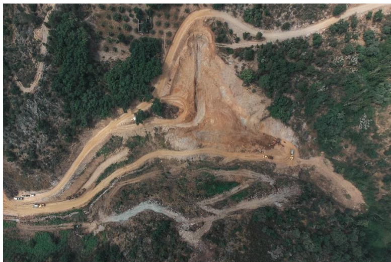
Vista aérea escavação encontro esquerdo – junho 2024
