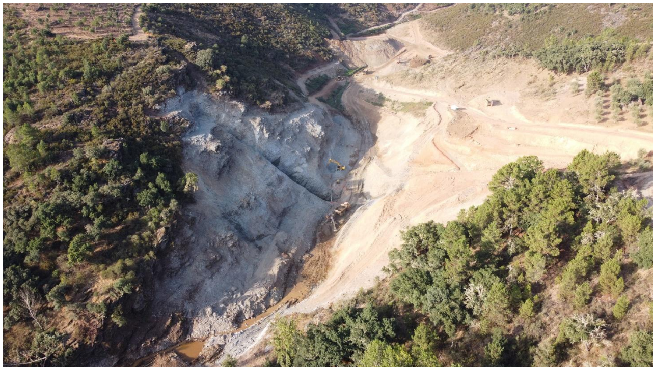
Escavação encontro direito – julho 2024
