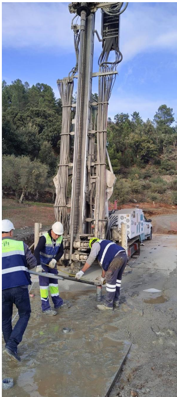
Início da furação no trecho experimental de injeções (5) – dezembro 2024
