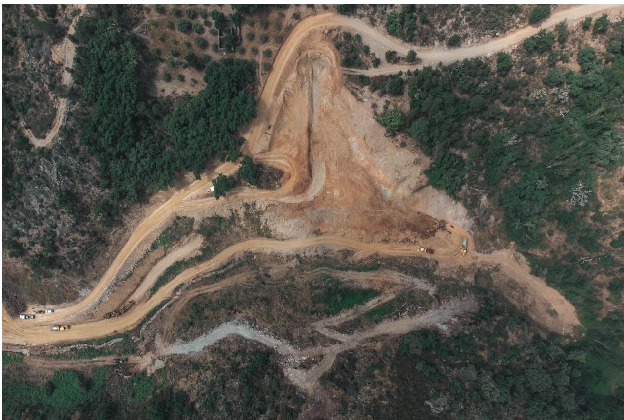
Escavação encontro esquerdo – junho 2024
