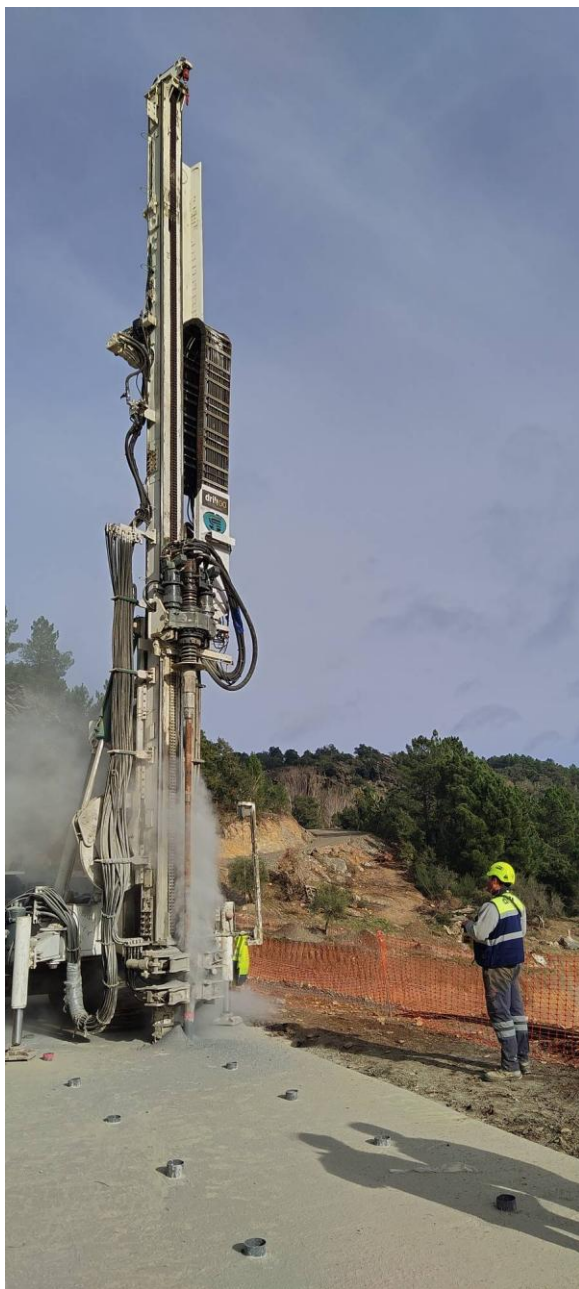
Início da furação no trecho experimental de injeções (5) – dezembro 2024
