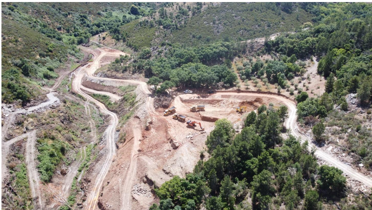
Abertura de caminho de acesso – maio 2024
