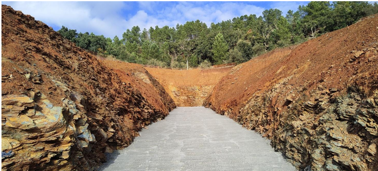
Aplicação betão regularização (Encontro direito) – novembro 2024
