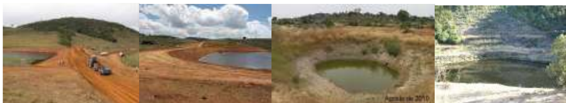
Figura 8 – Construção e Manutenção de Pontos de Água Municipal.
