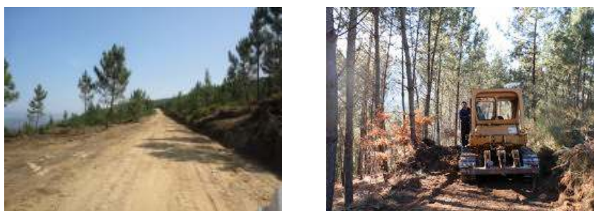
Figura 7 – Construção e Manutenção da Rede Viária Florestal.
